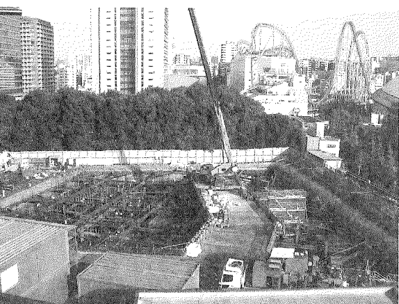
工事が進む新1号館(3号館から見る) 背景は文京区役所や後楽園遊園地など
