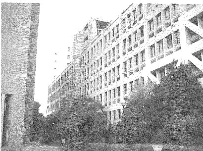
南側(2007年頃耐震補強されている)
