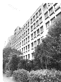
一号館の南面を見る
